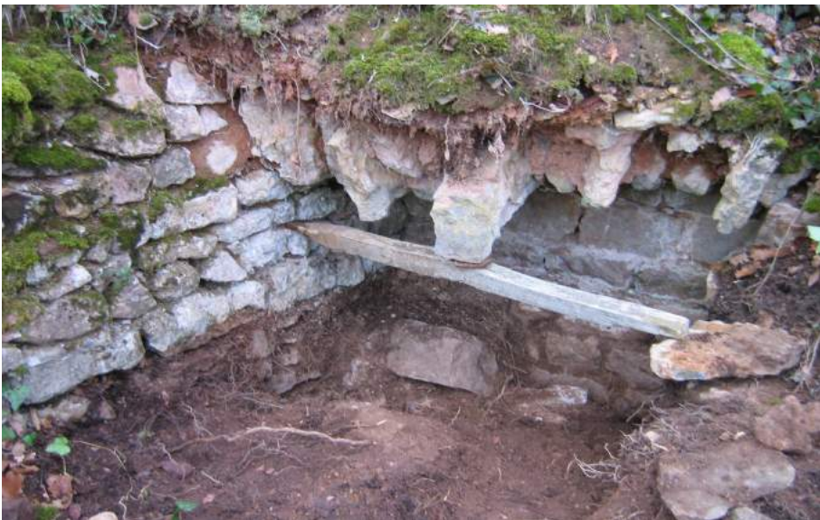
Ancien four à chaux à Varanges
